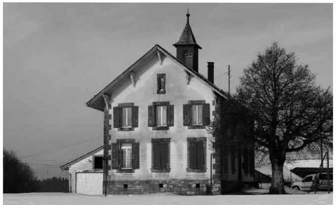
Collège du Martinet, sur la commune de Savigny.
